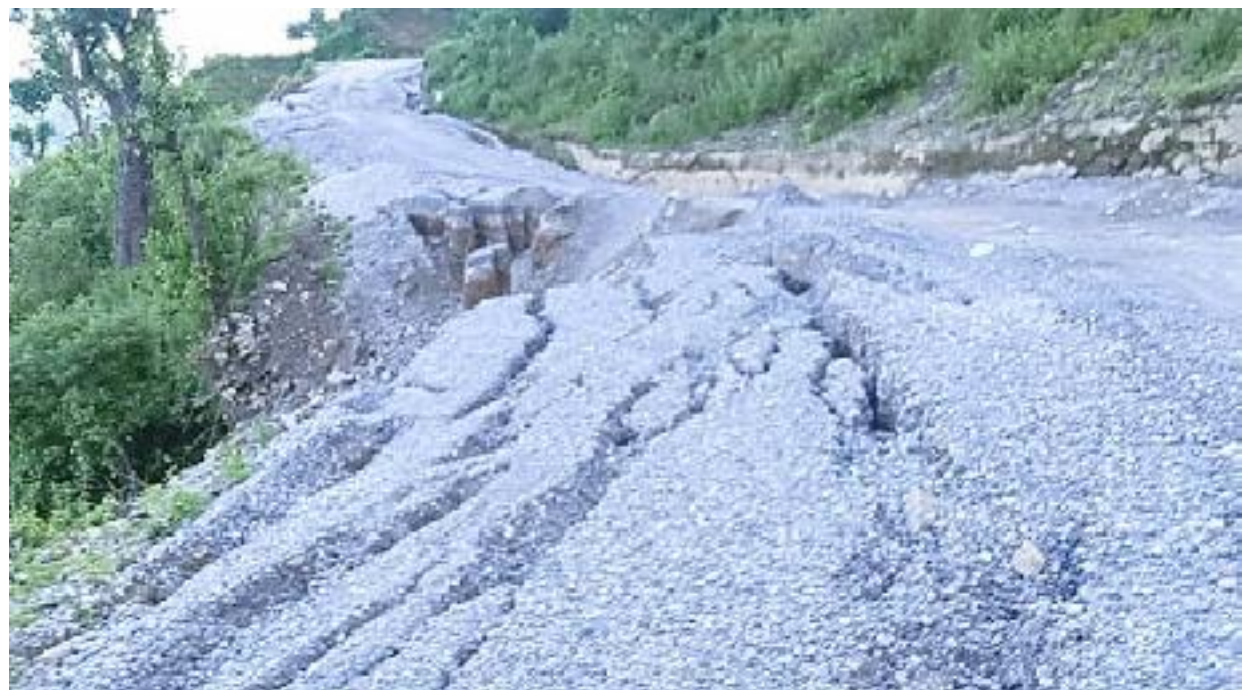
उदयपुर जिल्लाको सदरमुकाम गाइघाटदेखि खोटाङ जिल्लाको दिक्तेल जाने सगरमाथा लोकमार्ग १३३ किलो मिटर अर्न्तगत त्रियुगा नगरपालिकाको वडा नं. १५ खाँवु राटमाटे ३५ किलो मिटरमा भासिएको सडक। तस्विर - बुद्धि कुमार राई
