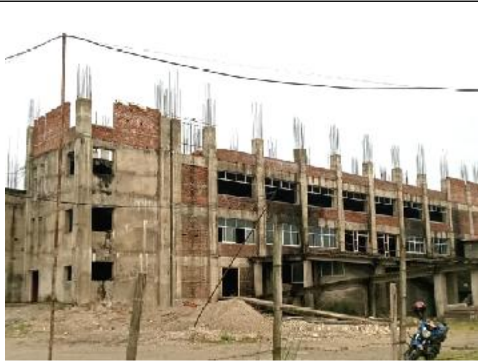
उदयपुर जिल्लाको सदरमुकाम गाईघाटको त्रियुगा नगरपालिका १३ पुरानो गाईघाटमा निर्माण भईरहेको २७ करोड ७० लाख लागतको मदन भण्डारी सभाहल निर्माण कार्य भईरहेको छ। निर्माण कहिले सकिने भन्ने अबै टुडगो लागेको छैन। तस्विर - बुद्धि कुमार राई
