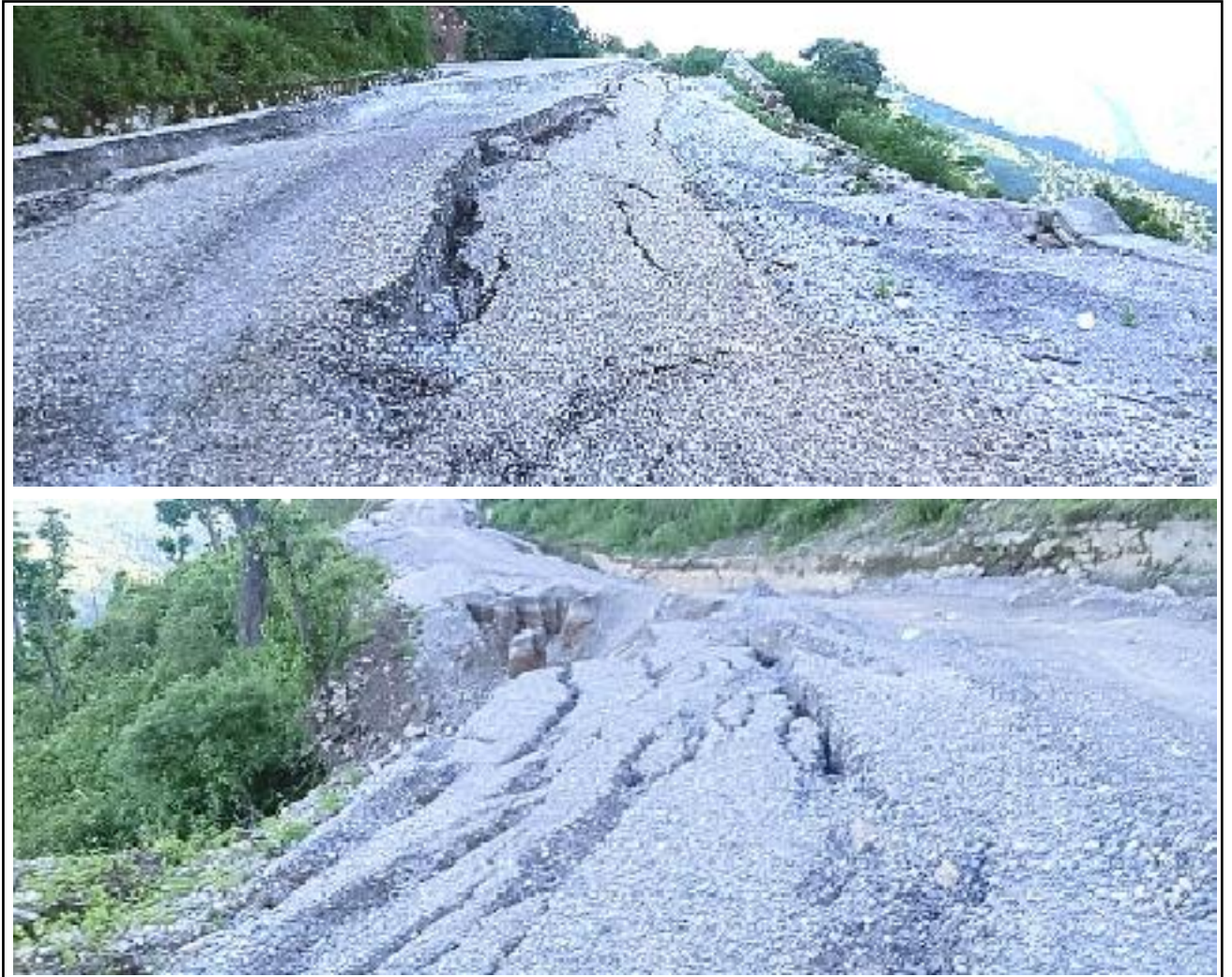
उदयपुर जिल्लाको सदरमुकाम गाइघाटदेखि खोटाङ जिल्लाको दिक्तेल जाने सगरमाथा लोकमार्ग १३३ किलो मिटर अर्न्तगत त्रियुगा नगरपालिकाको वडा नं. १५ खाँवु राटमाटे ३५ किलो मिटरमा भासिएको सडक। तस्विर - बुद्धि कुमार राई
