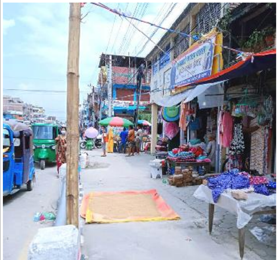
सडक पेटिमा धानको बिस्कन । उदयपुर जिल्लाको सदरमुकाम गाईघाट बजारको सडक पेटिमा धानको बिस्कन लगाएर सडकपेटी अवरुद्ध हुँदा पैदलयात्रु मारमा परेका छन् । सडकपेटी नै अवरुद्ध भएका कारण पैदलयात्रु मुल सडकबाट हिड्नु पर्दा सडक दुर्घटनाको जोखिममा बढेको छ । तस्विर - मुलुकी
